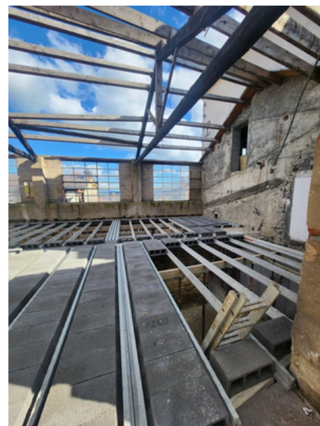
Future salle de restaurant
