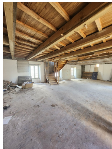
Rez-de-chaussée de la partie tiers-lieu
