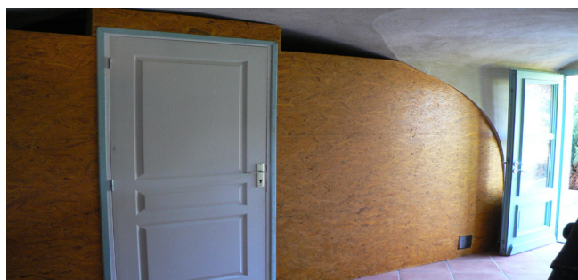
Création d'un local de stockage dans la salle des associations par M. DE RYCKE
