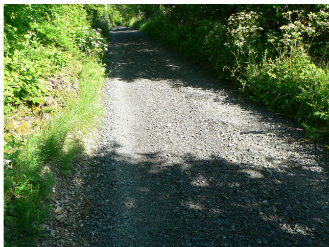
Empierrement au chemin de la Garde
